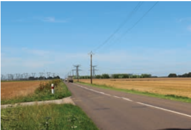
Vue rapprochée (environ 900 m), depuis la RD2, à 10 ans
