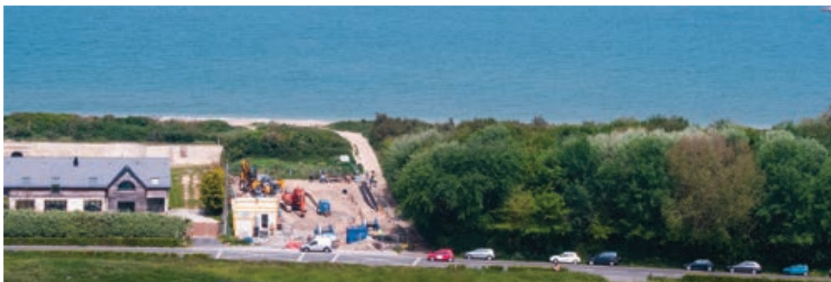
Chantier de l'atterrage de l'interconnexion IFA2 (Calvados)
